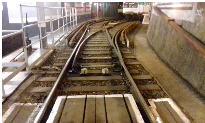
Appareil de voie en position Gauche
