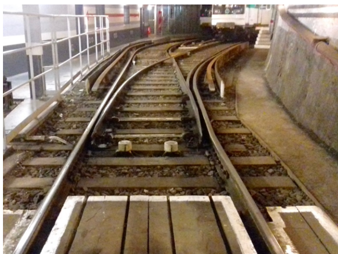
Appareil de voie entrebâillé
